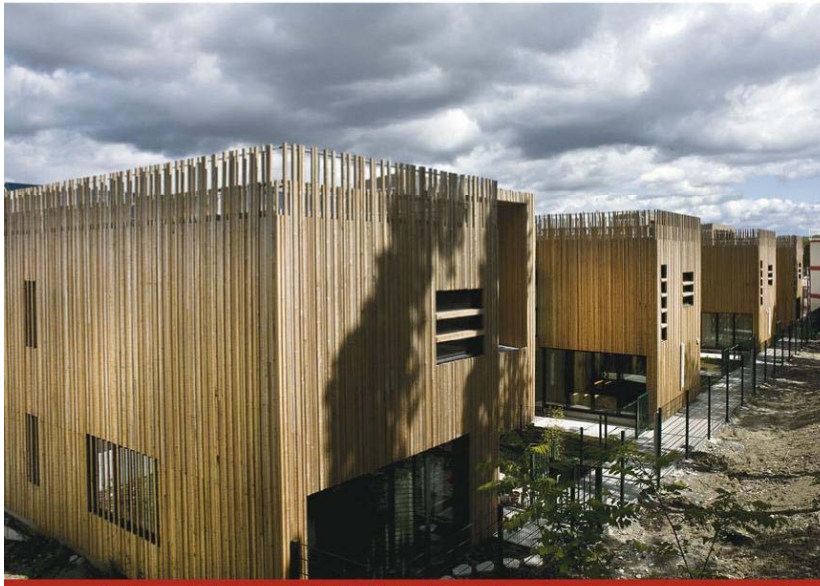
A Clichy-sous-Bois, le collège Louise-Michel est un bâtiment à énergie zéro. Il est en outre doté d'une piscine.
